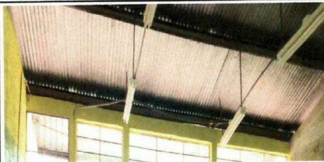
Foto 2: Mantenimiento a estructura.
